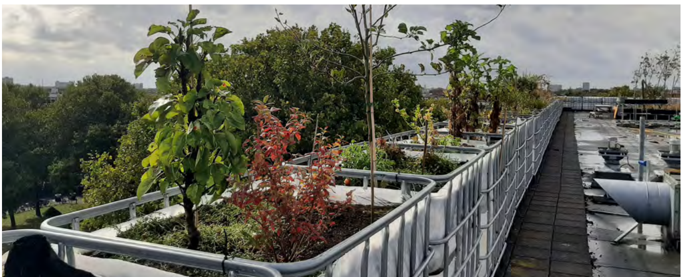
hergebruikte IBC-containers op het dak van de EnergieKas © Rooftop Revolution
