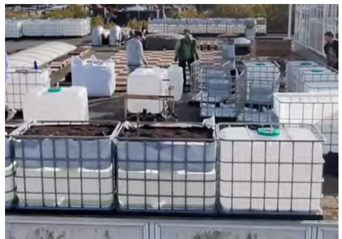
Tijdens de DakPlanterij DakDoeDag hebben burens planters met regenwateropslag gemaakt van gerecyclede IBC-containers en deze als dakreling toegepast. In samenwerking met Laboratory for Microclimates en anderen © EnergieKas
