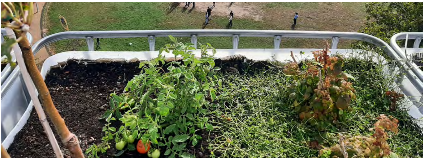
IBC-containers als borstwering bij de EnergieKas © Rooftop Revolution
